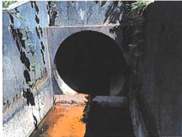
Emergency spillway conduit
